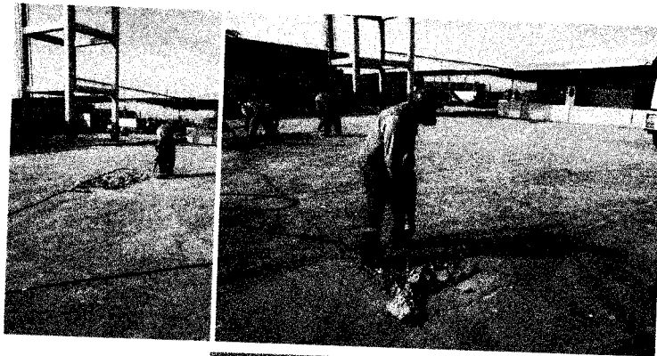
DEMOLICIÓN DE PISO EN PATIO DE MANIOBRAS
